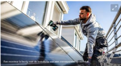
Foto: momenteel in beeld met de installatie van een zonnepaneel op een dak.
